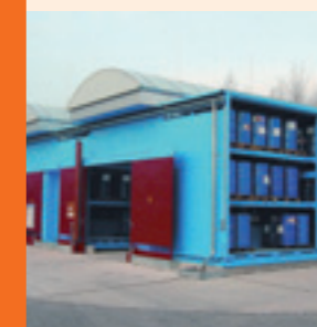
Fertigwarenlager mit schwenkbaren Löschwasserbarrieren
